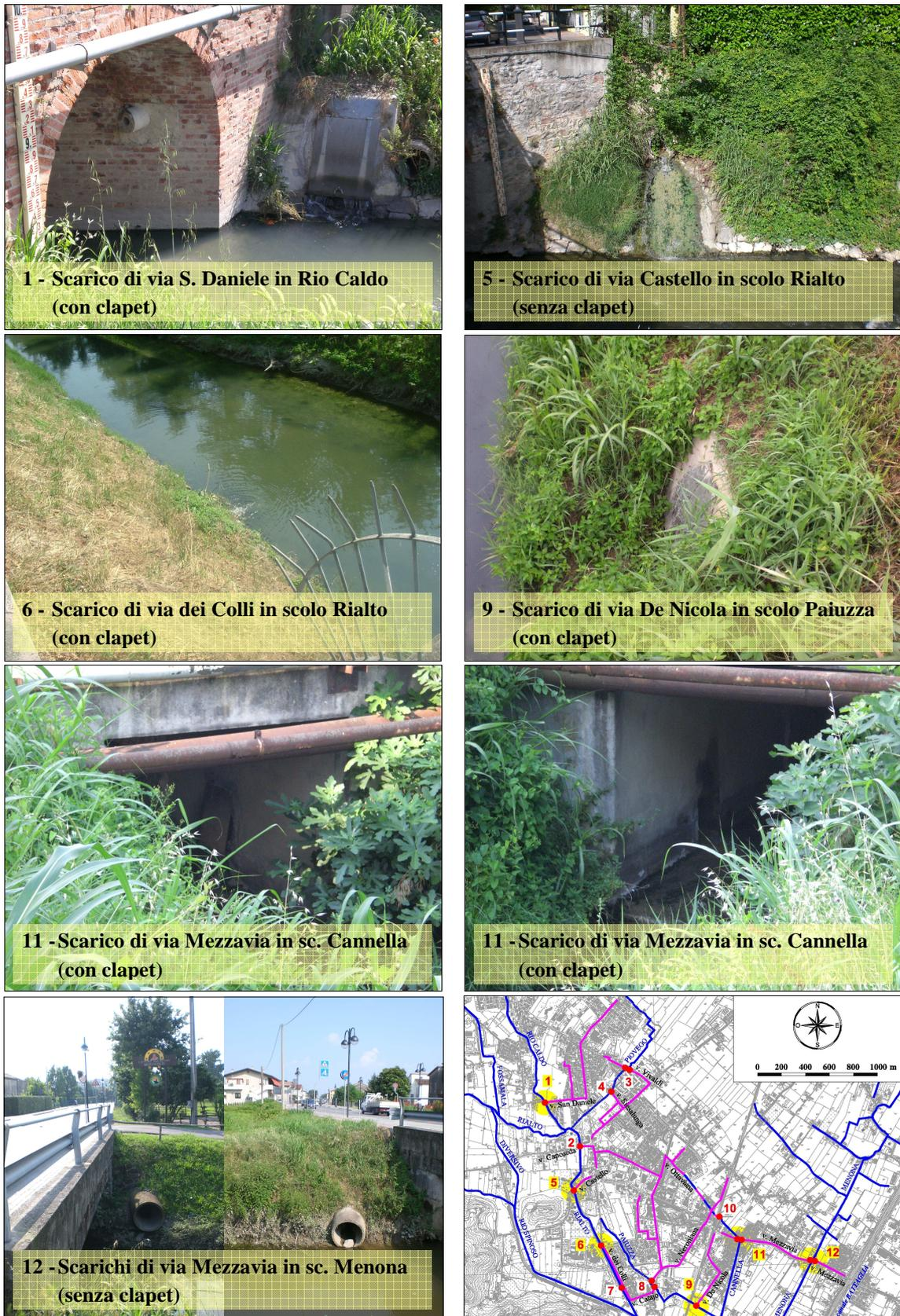
Fig. 4.6 - Fotografie di alcuni scarichi della rete fognaria principale di Montegrotto Terme, la cui posizione (n. 1, 5, 6, 9, 11, 12) è evidenziata in giallo sulla corografia.
